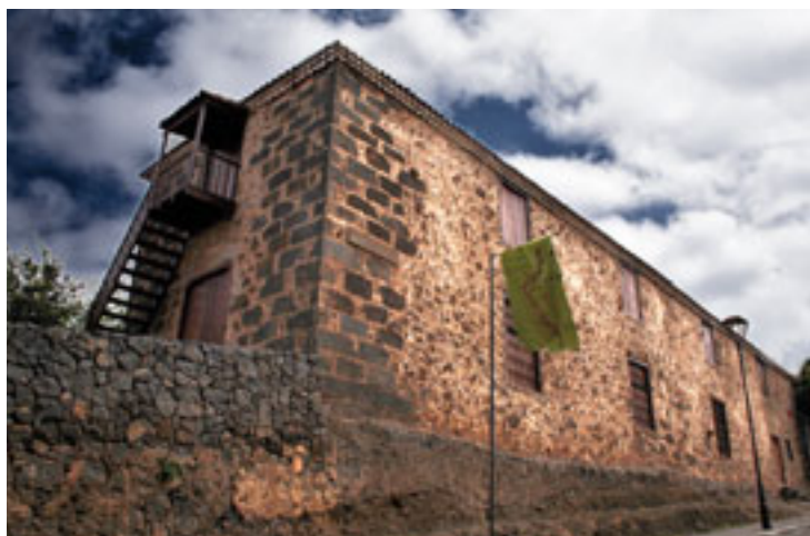
FIG.2. La Alhóndiga, Tacoronte
